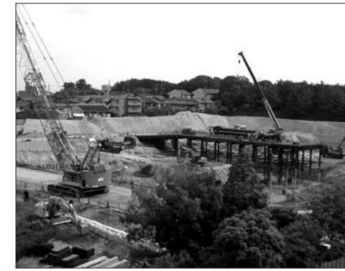
▲建設現場 (25年9月14日撮影)
