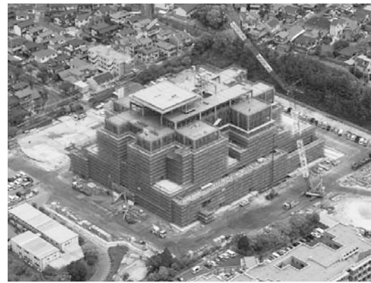
▲工事現場写真 (26年5月19日撮影)
